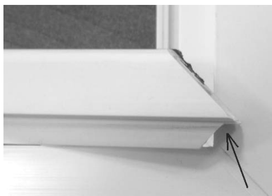
Рис.6 При оптимальной настройке подрезная пила (малый диск) должна вырезать ступеньку со стороны ножки штапика на 2-3мм, тем самым, обеспечивая плотную посадку в угол оконного блока.
